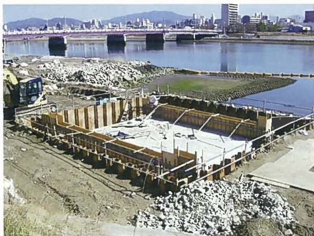
写真-13 地覆コンクリート型枠
