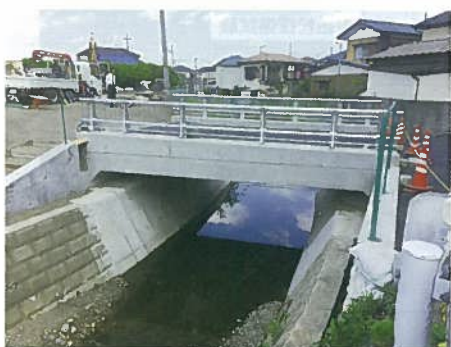
埼玉県人間市役所 西武6号橋架け替え工事
