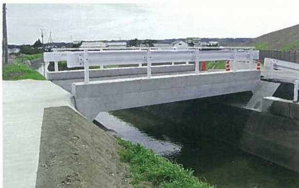
写真-1 施工例(農業用水路)
