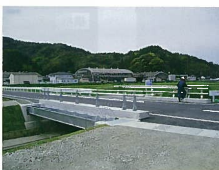
宮崎県日南市役所 市道鳥越線道路改良工事
