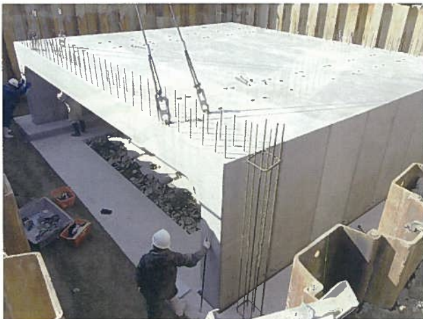
写真-12 8個目の設置
