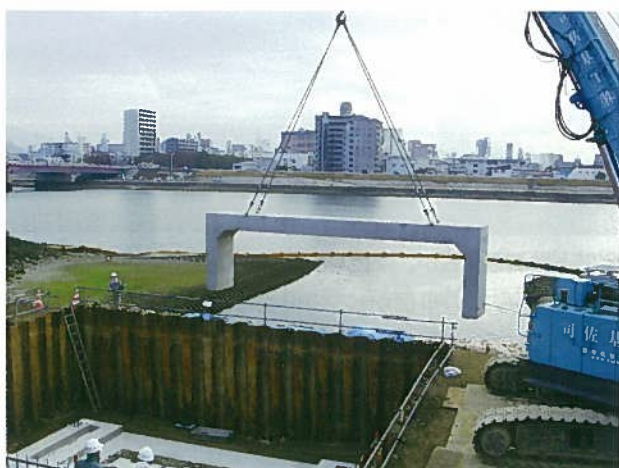
写真-7 斜角門形カルバートの吊込み
