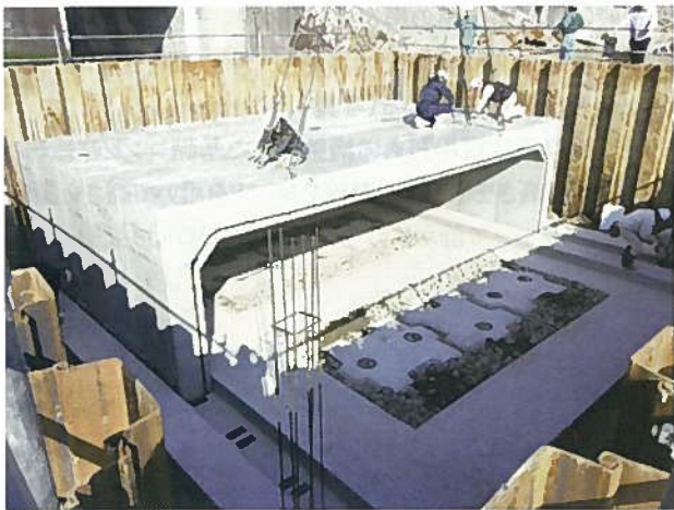
写真-11 頂版の引寄せ
