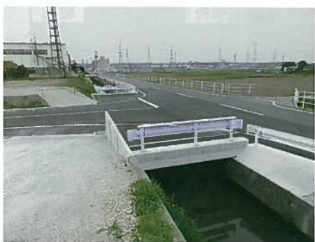
愛知県大府市役所 道路改良工事(市道5049号線ほか)
