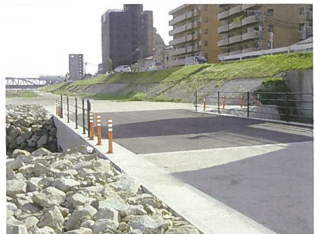
写真-15 工事完了(上流側より堤防下流方向)
