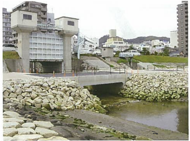
写真-14 工事完了(下流側より水門方向)
