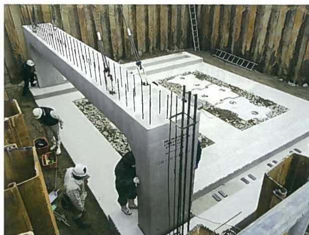
写真-9 1個目の設置
