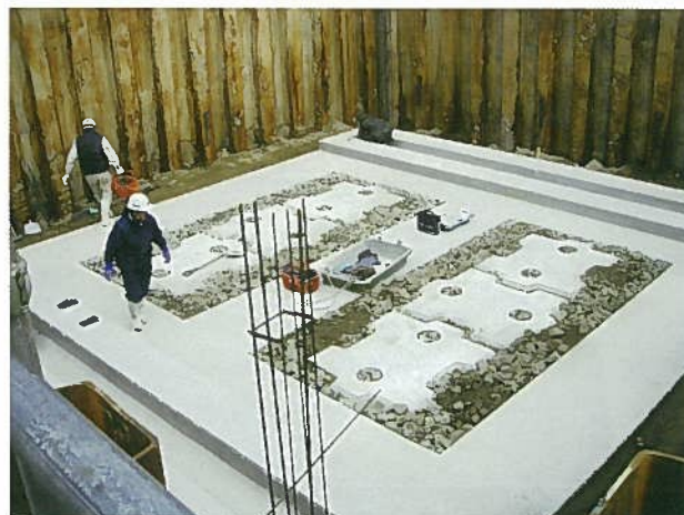
写真-4 基礎コンクリート
