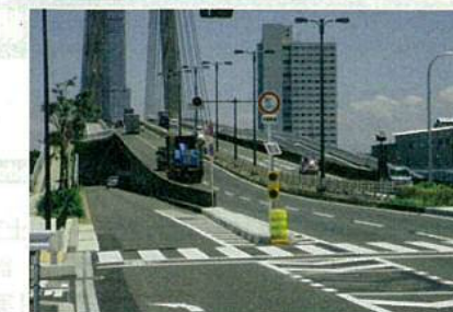
大阪府道63号線りんくうポート南
