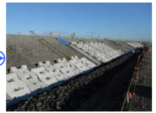
平成25年1月の築堤作業の状況
