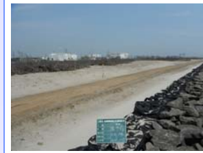
平成24年5月 本復旧工事着手前の状況
