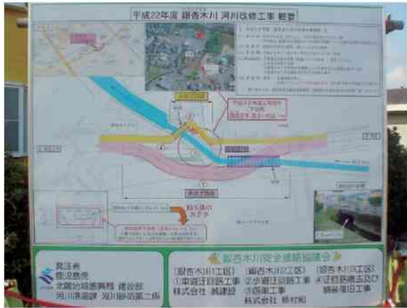
写真-7 付近住民への工事説明看板
