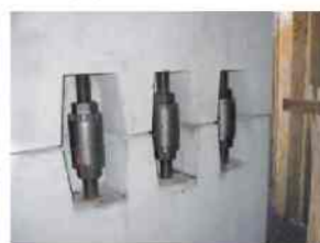
写真-25 接合完了
