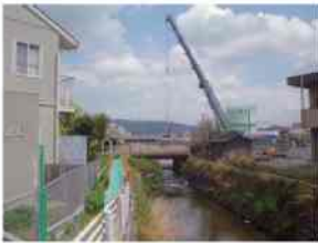
写真-5 下流側改修区間
