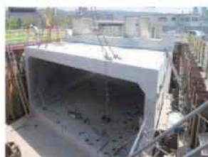
写真-26 14/18函設置
