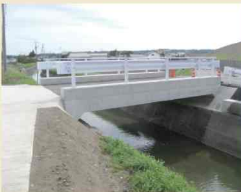
宮崎県西都市役所 旭村地区非難道路整備工事
