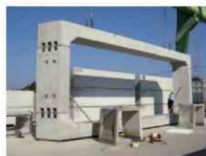
写真-3 工場での仮組
