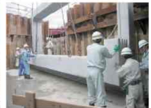
写真-13 底版設置
