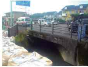
写真-6 今回改修区間 上流側(3.35m x 1.50m)
