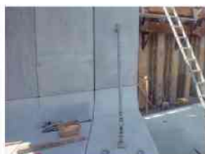
写真-17 サポートの取付
