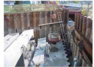
写真-11 敷きモルタル
