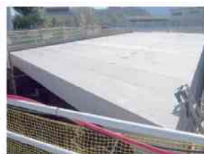
写真-27 18函設置完了
