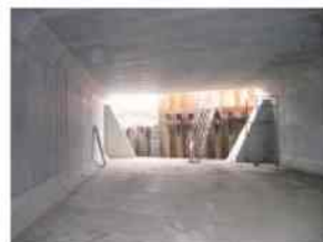
写真-29 摺付コンクリート設置
