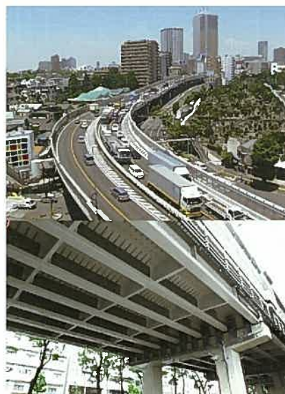
グラビア:首都高速5号池袋線床組構造改築工事1-81
