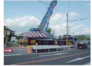
写真-9 220t吊クレーン
