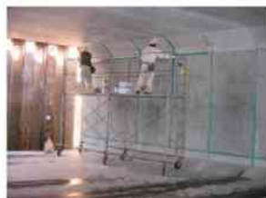
写真-28 目地作業状況
