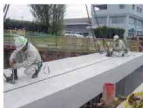
写真-21 高力ボルト締付
