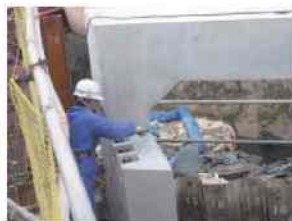
写真-15 接合面接着剤塗布
