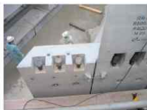
写真-19 側壁上部引寄せ
