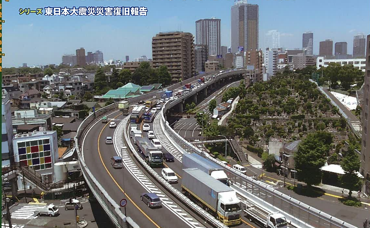
首都高速5号池袋線 床組構造改築
