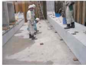
写真-10 鋼製プレート
