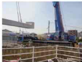
写真-12 クレーン吊り上げ
