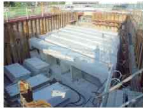
写真-8 製品の仮置
