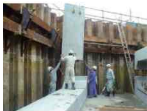
写真-14 側壁の設置
