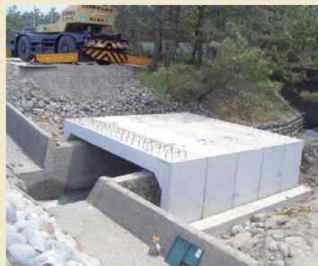
北陸地方整備局黒部河川事務所 下新川海岸直立堤災害復旧工事
