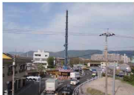
写真-2 現場周辺(国道267号)
