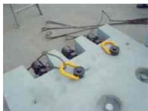
写真-16 側壁吊り金具
